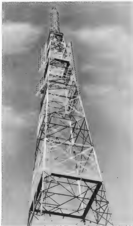
Bild 7. Die Fernseh-Antennenanlage der RAI auf dem Monte Peglia (Italien)
